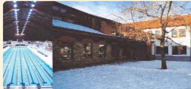
Eger, AGRIAQUA Verseny és Tanuszoda épületgépészeti kivitelezés; Üröm, Általános Iskola épületgépészeti kivitelezés
